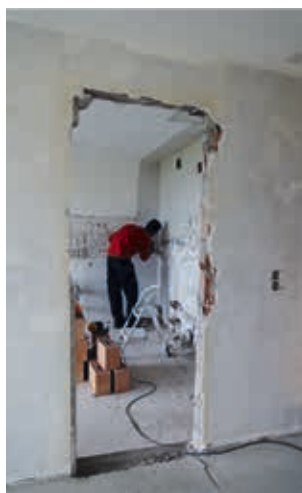
Sanierungsarbeiten in der Küche
