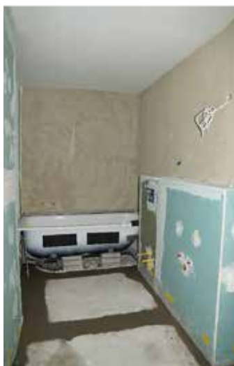
Badezimmer im Rohzustand
